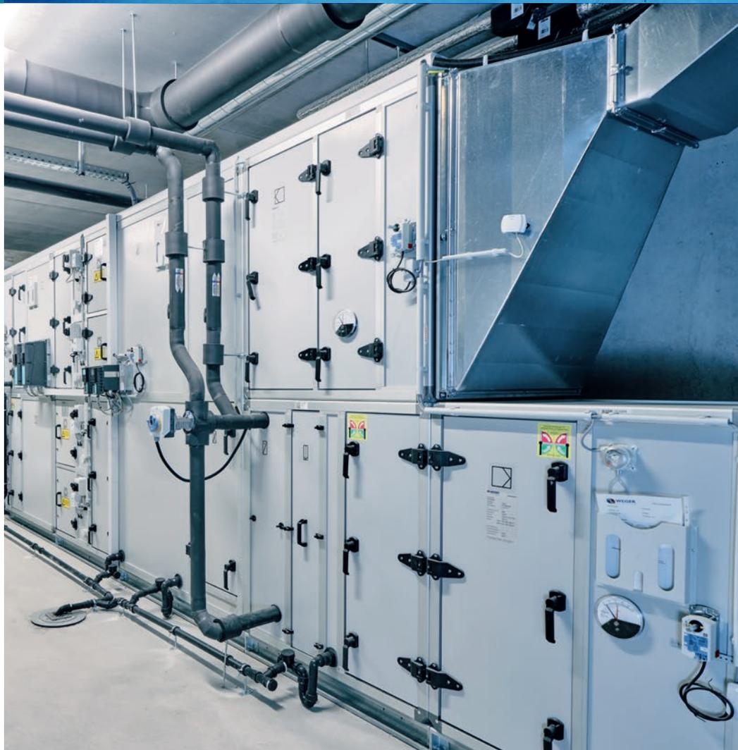
Glanzeistung im Bestandsgebäude: Hygienelüftungsanlage nach DIN 1946/4, Gesamtluftleistung 5.000 m<sup>3</sup>/h mit WRG Klasse H1, aufgrund hoher Gesamteffizienz gefördert innerhalb BEG Sanierungsprogramm.
