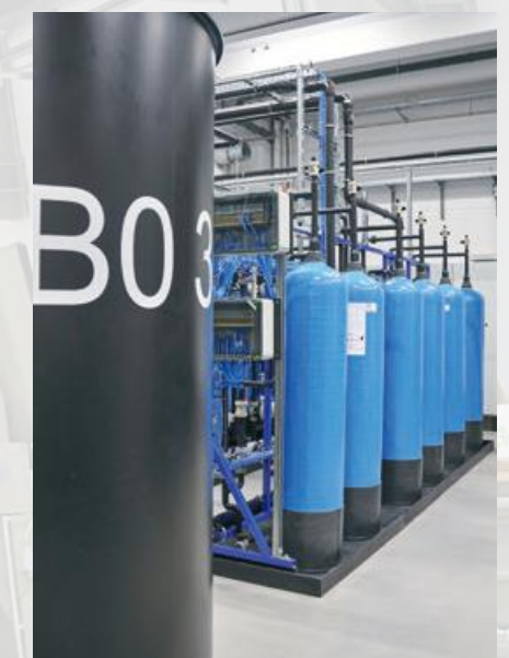
Alles sauber: Im Neutralisationsbereich werden die Galvanikmedien aufbereitet und recycelt.
