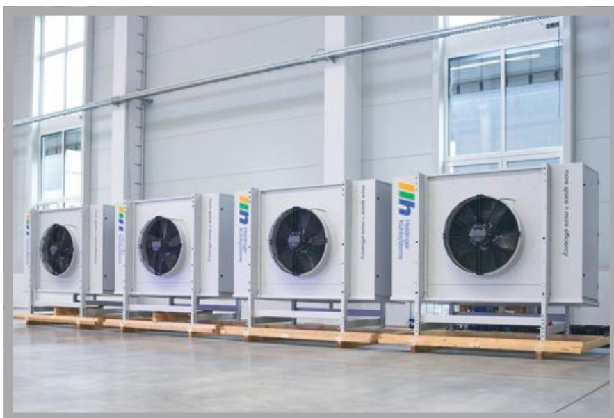
Für noch bessere Energiegewinnung aus der Außenluft: Hocheffiziente Verdampfer in XXXL Ausführung.
