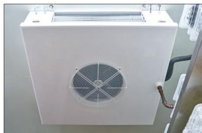
Luftkühler, speziell ausgelegt für hohe Drucklagen.
