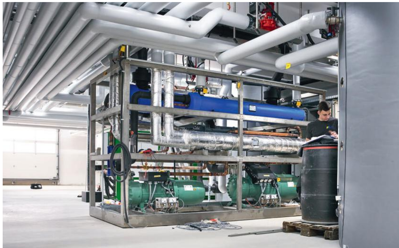
Live bei der Inbetriebnahme: 2-stufig aufgebautes Wärmepumpen-Kälteaggregat von Heidinger.
