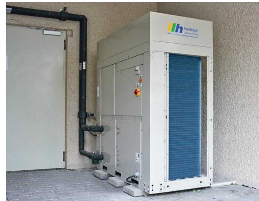
Da steckt viel drin: Die Luft/Wasser-Wärmepumpe mit dem LowGWP Kältemittel R32 und voll drehzahlre-
