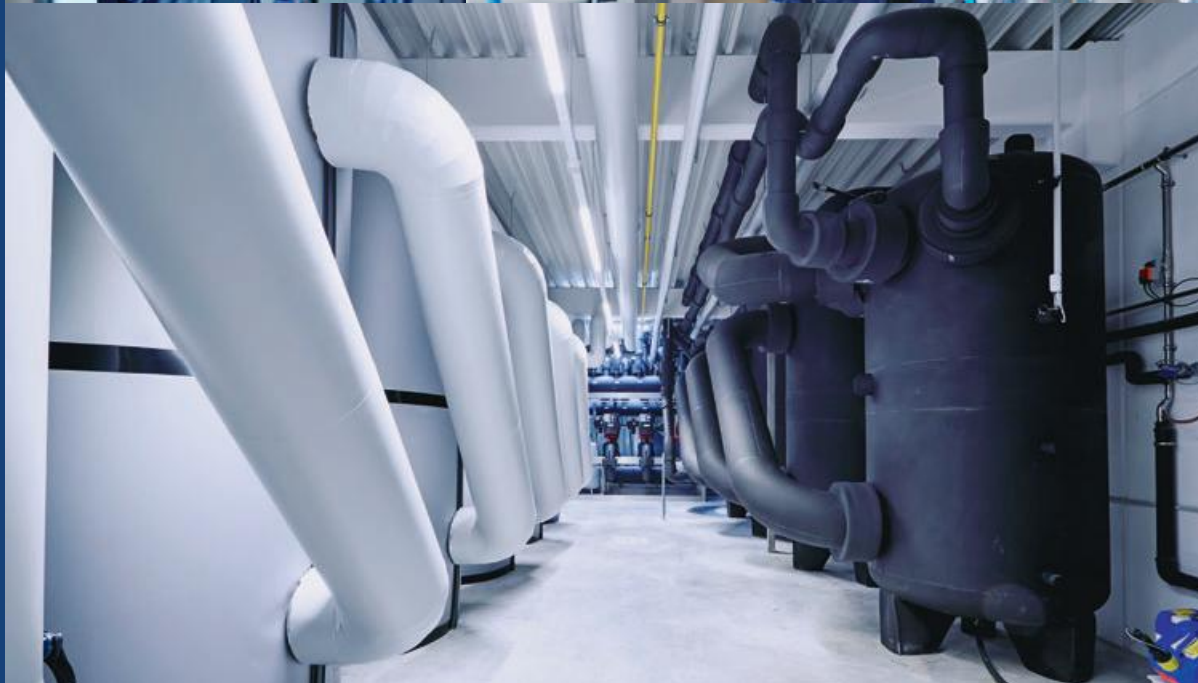
Hot oder on the rocks? Leistungsfähige Puffer speichern die thermische Energie für Prozesse und die TGA.
