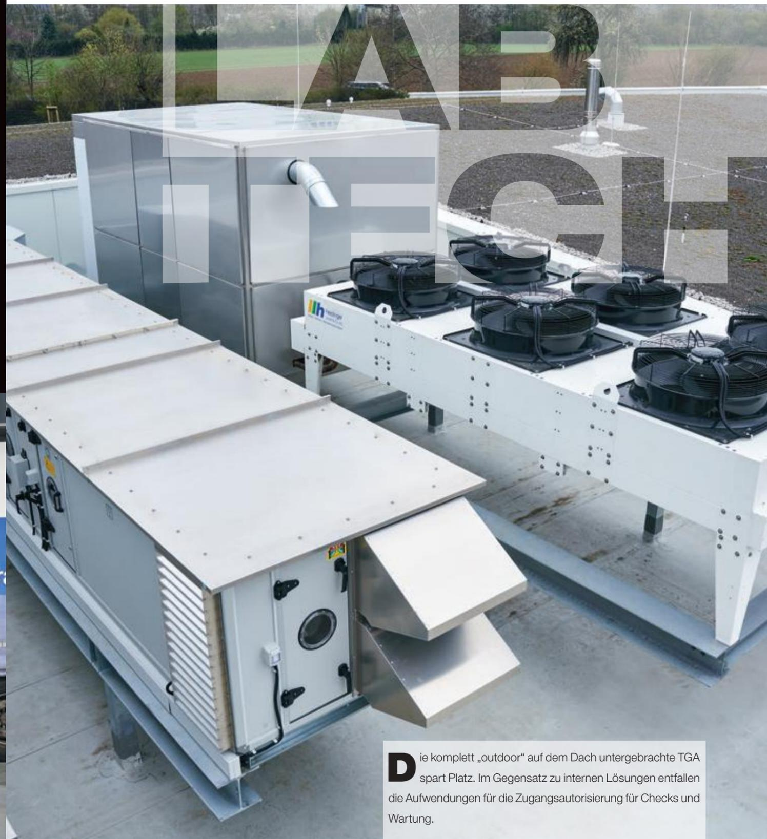
**D**ie komplett „outdoor“ auf dem Dach untergebrachte TGA spart Platz. Im Gegensatz zu internen Lösungen entfallen die Aufwendungen für die Zugangsautorisierung für Checks und Wartung.
