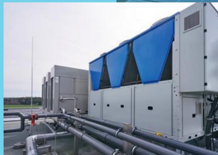
Zentrale Kaltwassererzeugung für den Bauabschnitt 4.
