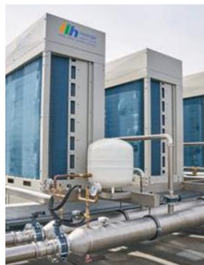
Gute Ideen machen die Standardtechnik zum Allroundtalent ... und Kunden glücklich. Mit Heidinger Eigenentwicklungen können die Luft-Wasser-Wärmepumpen hydraulisch so geregelt werden, dass das Gebäude (je nach Anforderung) gleichzeitig gekühlt und geheizt werden kann.
