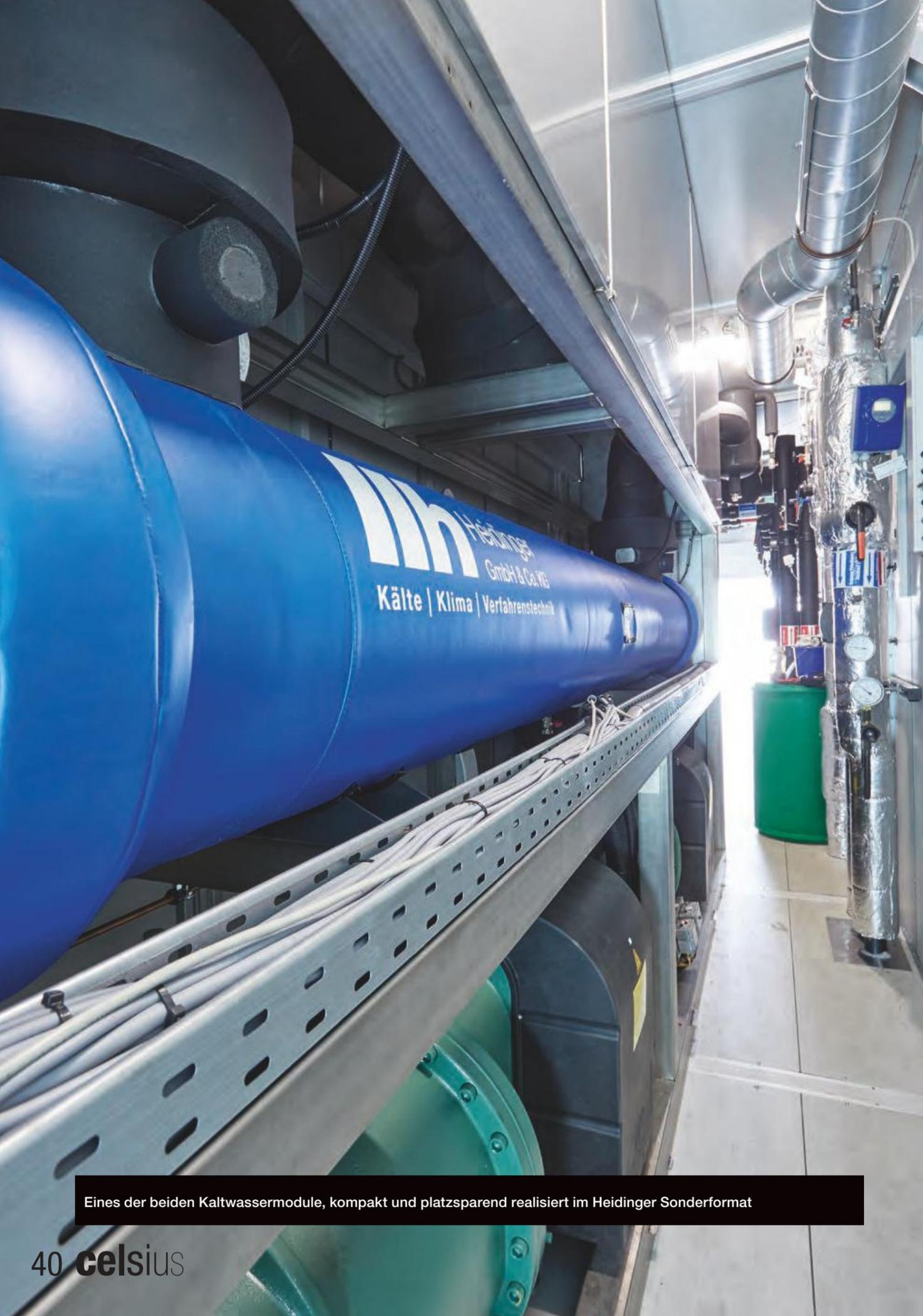
Eines der beiden Kaltwassermodule, kompakt und platzsparend realisiert im Heidinger Sonderformat
