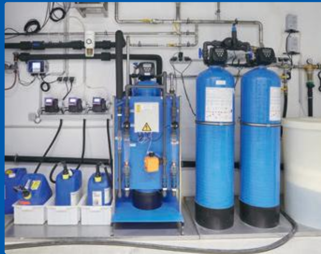
Wasserbehandlungsanlage für die Prozesskühlung und adiabatisches Sprühsystem für den Rückkühler
