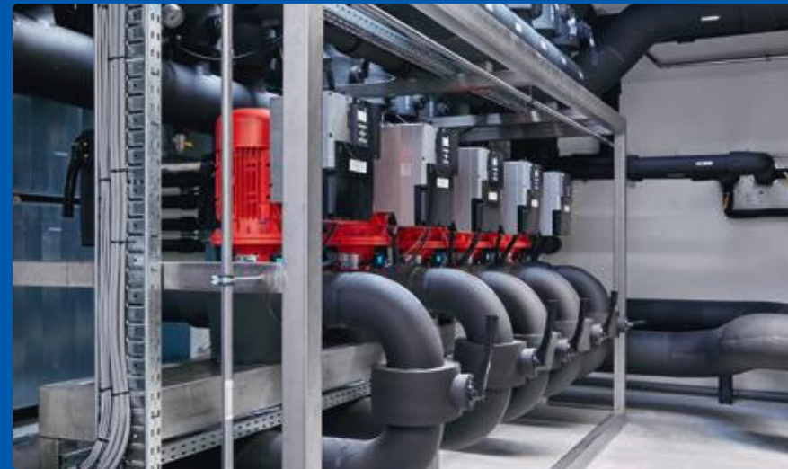
Zentrale Pumpstation für die gezielte Verteilung von Heiß-/Kaltwasser sowie Versorgung des Rückkühlwerks
