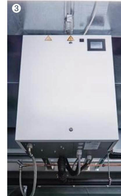
2 Zentrale Schalt- und Steuerungstechnik sowie Fernüberwachungsmodul.
