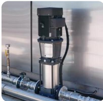
Schnittstelle Förderpumpe für den Wärmeübertrager.
