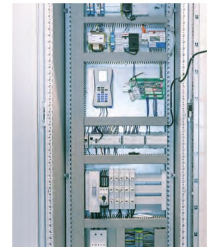
**Individuell zugeschnitten: Zentrale Schalt- und Steuerungstechnik mit Fernüberwachungsmodul.**
